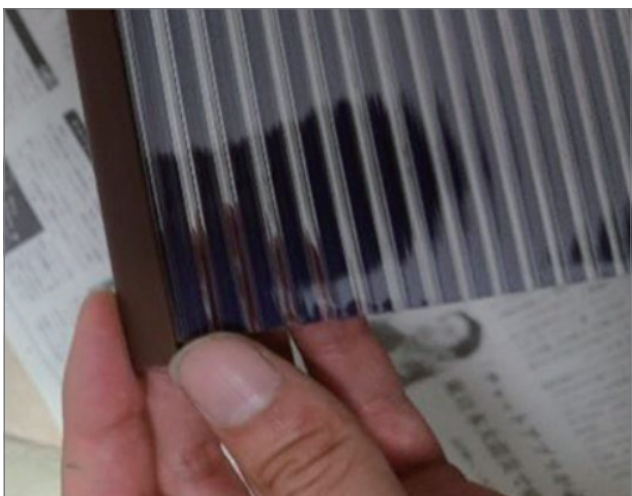
ポリカーボネートの内窓を作成中
