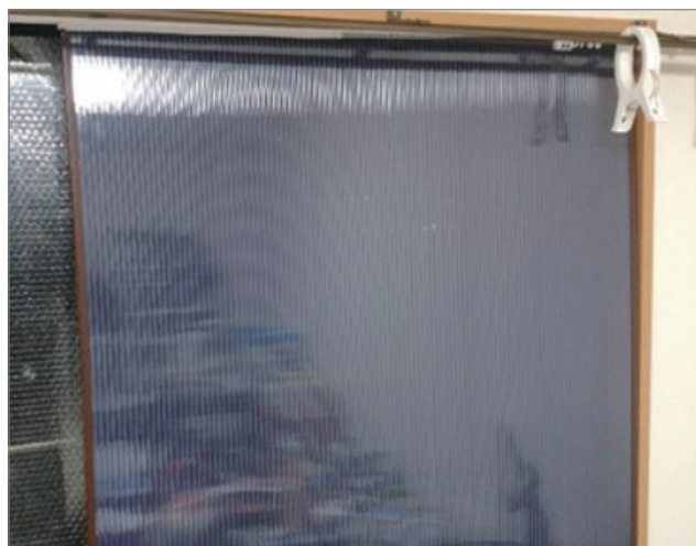
内窓を取り付けたところ
