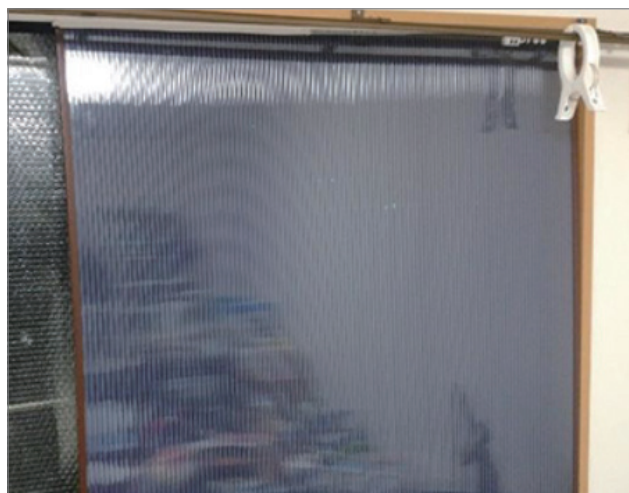
内窓を取り付けたところ
