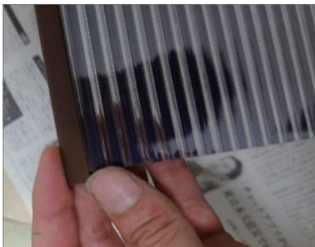
ポリカーボネートの内窓を作成中
