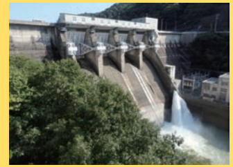
鹿野川ダム(愛媛県大洲市)
