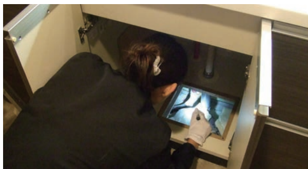
写真 点検口から排水管のようすを確認
