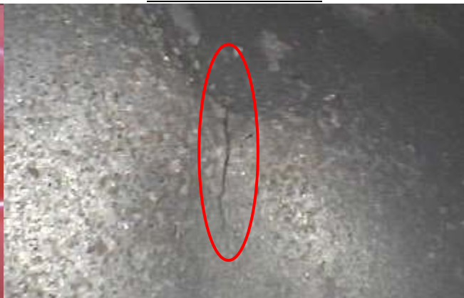
写真2. 内面の亀裂
