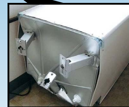
▲写真1 東日本大震災で 電気給湯設備の貯湯タンクが倒れた例※1
